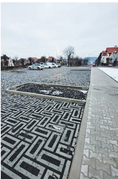
Vloni vyrostlo v Husově ulici nové parkoviště pro 40 vozidel. To je však jen polovina stavby. Letos k nim zde přibude ještě dalších 40 míst.
