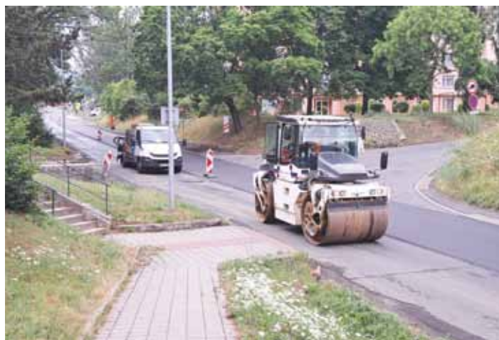
O měsíc a půl dříve oproti původnímu harmonogramu skončila oprava povrchů v ulici Daliborova. Foto: Radim Tuček
