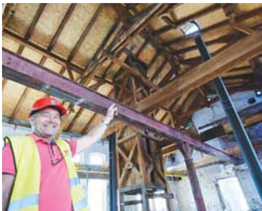
Stavbyvedoucí Stanislav Rožánek ukazuje na jednu ze stropních konstrukcí, které byly postaveny v minulých týdnech. Foto: Eva Břeňová
