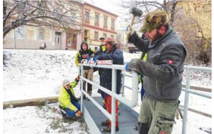
Ztrouchnivělé dřevěné prkno přes Pokratický potok nahradil nový kovový mostek. Foto: Radim Tuček
