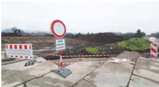
Výstavba je v plném proudu. Foto: Eva Břeňová
