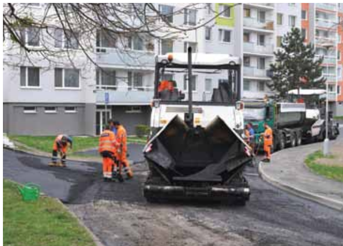
Opravy v ulici Werichova skončily o týden dříve oproti plánovanému harmonogramu prací. Foto: Radim Tuček
