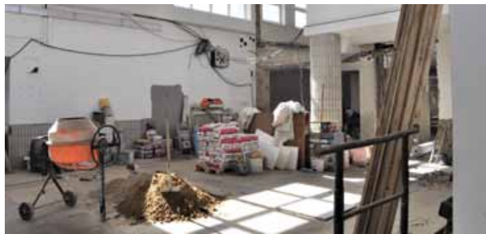
Výpravní budova dolního vlakového nádraží je v těchto dnech uzavřena. Jízdenku zakoupíte v provizorní pokladně venku. Foto: Filip Klieščík
