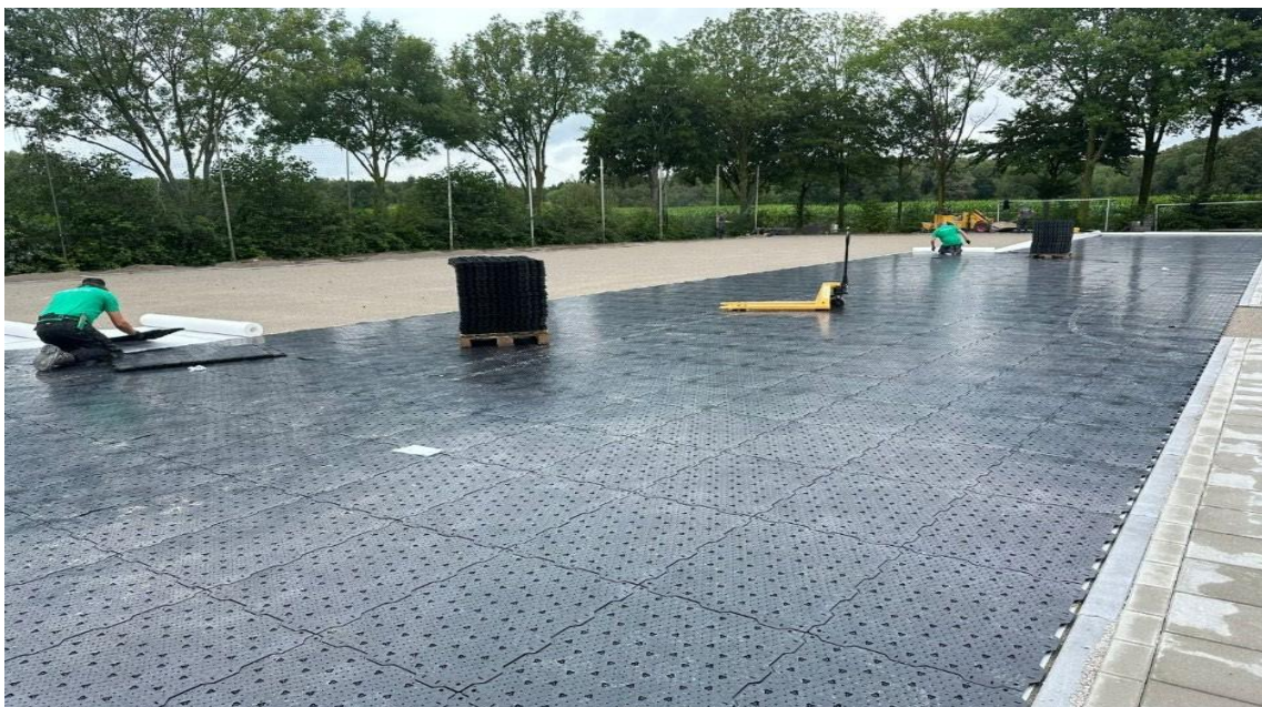
Obrázek 5 - instalace modulárních základních panelů
