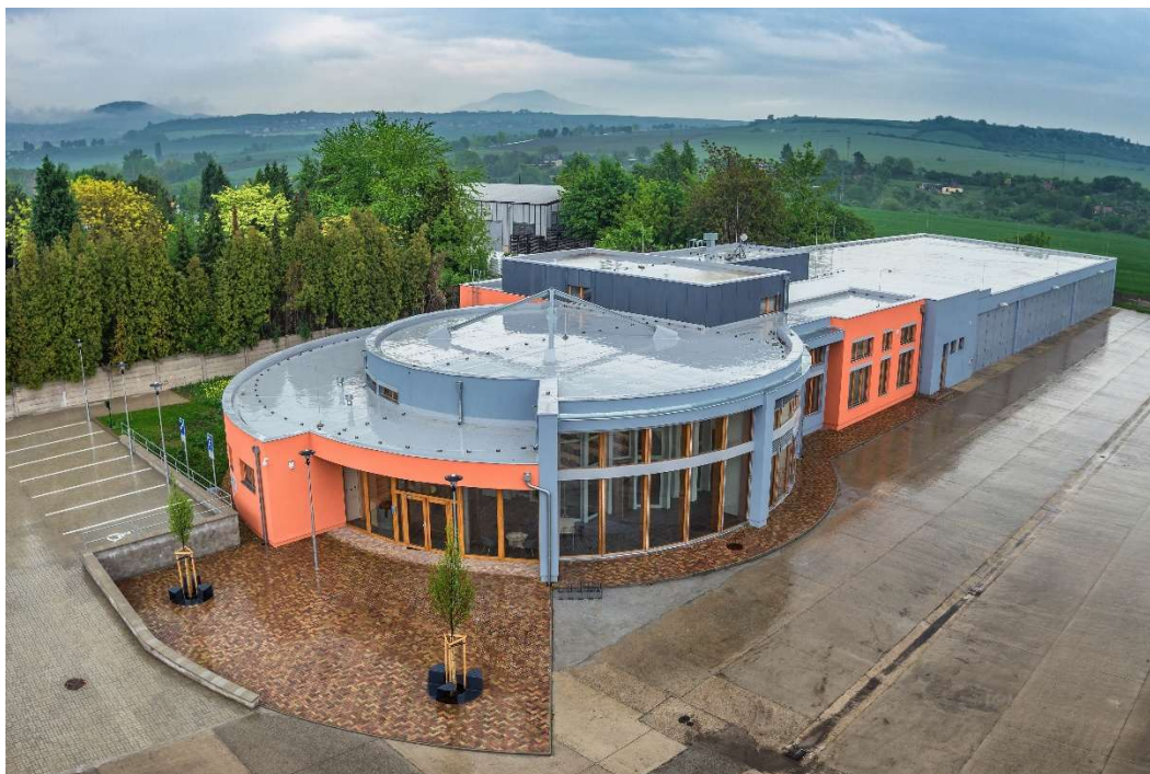
Budova výzkumného centra RINGEN
