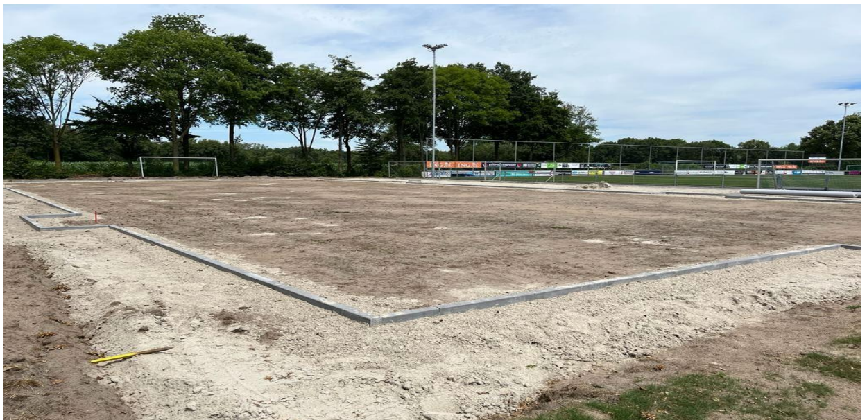
Obrázek 8 – příklad konstrukce základové desky z drceného kamene
